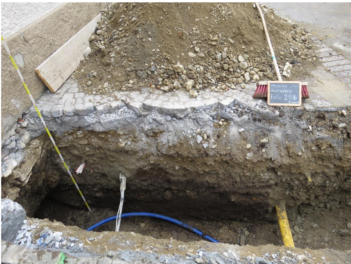
Abb. 2 Dunkelbrauner Lehm als unterste Schicht beim zur Wasserstraße liegenden Hausanschluss Schmiedgasse 4, Foto von Nordosten
