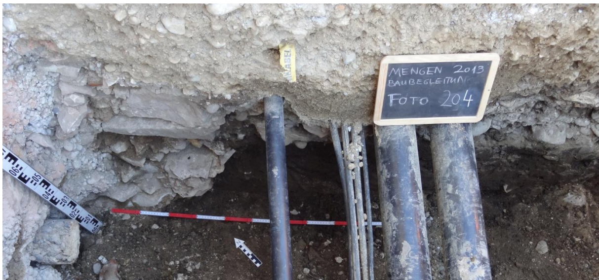
Abb. 4 Dunkelgraubrauner fester schluffiger Lehm 428 südöstlich des Kiesbetonfundaments des „Mohren“. Blick von Südwest.
